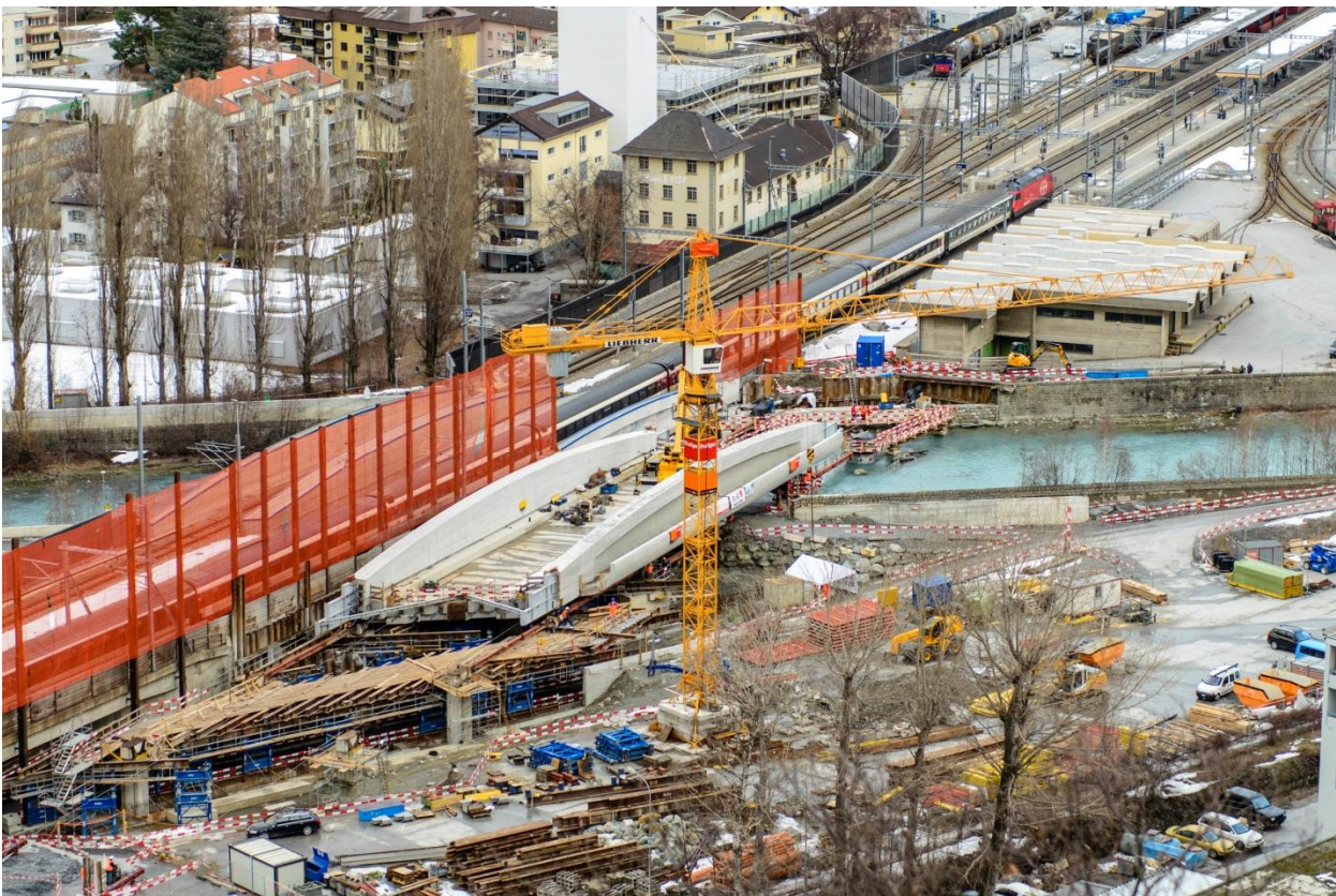
Übersichtsfoto Vispabrücke während dem Längsverschub über die Vispa
