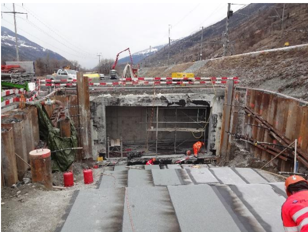
Zusätzlicher Abgang in bestehende Unterführung
