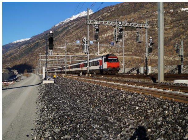
4. Gleis zum Südportal des Lötschbergbasistunnels (links)
