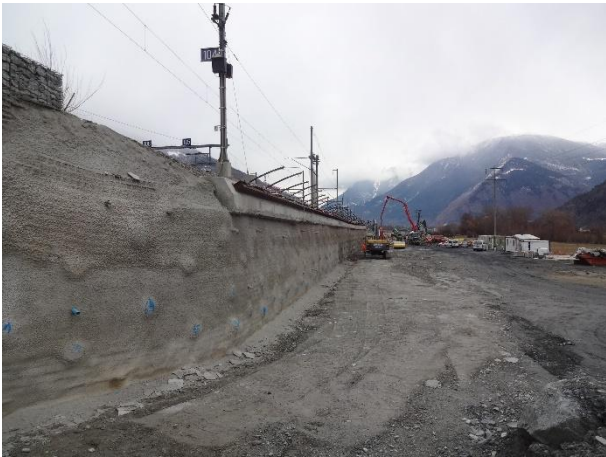
Rückverankerte Spritzbetonwand
