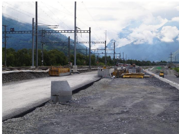
Trasséebau 4. Gleis, Stützmauer zwischen SBB und A9
