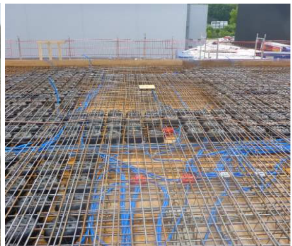
Bewehrung Decke mit Cobiax
