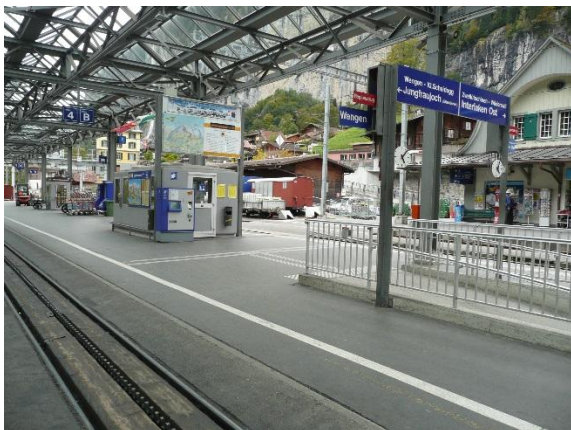
Anhebung der Perrons und Anpassung Unterführung
