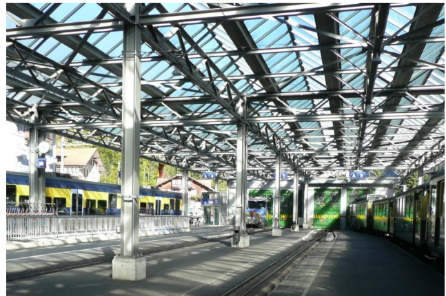
bestehende Perronanlage mit Überdachung
