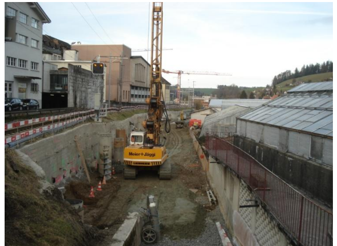
Bau Stützmauer entlang der Langete (temp. eingedohlt)
