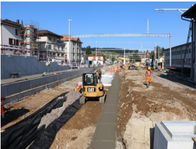
Tiefbauarbeiten während Totalsperre
