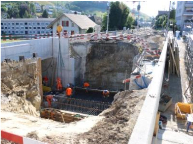
Bau mittlerer Teil der Unterführung während Totalsperre
