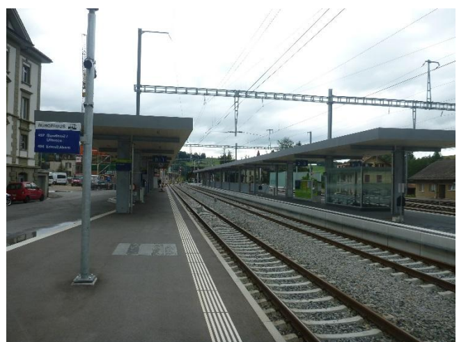
neue Perron P55, Unterführungen und Perrondächer
