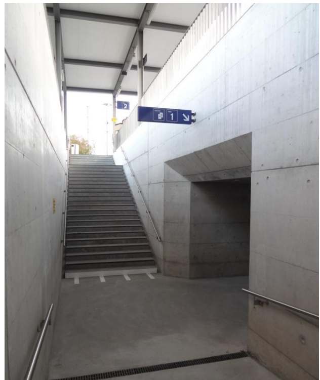
Unterführung als weisse, ungerissene Wanne
