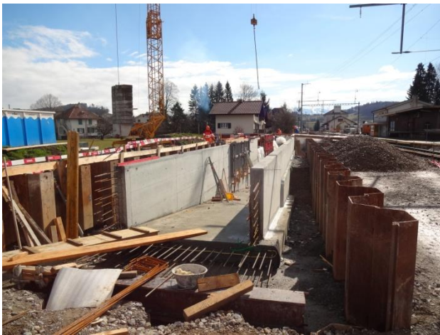
Bau der Rampe Ost (gespundete Baugrube)
