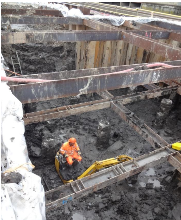
Baugrubenaushub zwischen Auftriebspfählen
