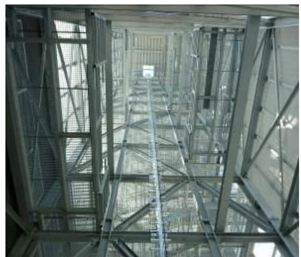
Innenansicht Stahlbau Übungsturm
