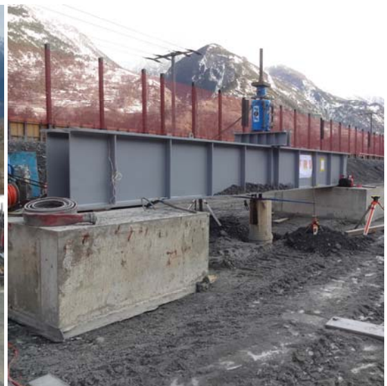
Belastungsversuch für Zugpfähle (2500 t)
