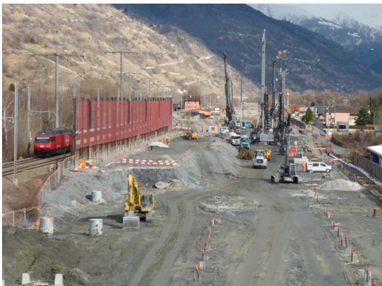
Bohrpfahlarbeiten Wanne West mit 4 Drehbohrgeräten
