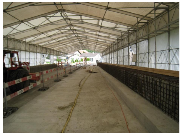
Überbeton und Verstärkung der Trogwände
