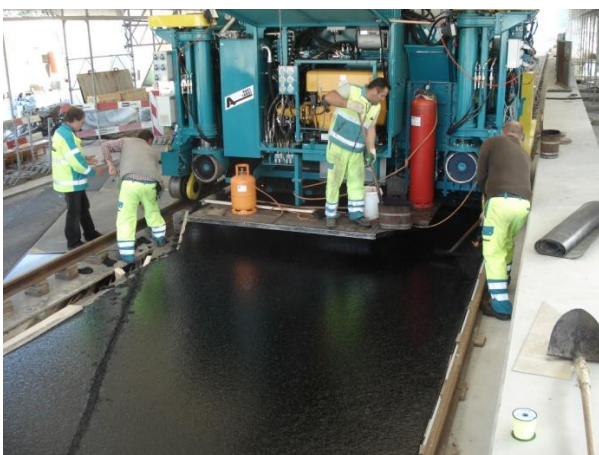
Einbau Gussasphalt
