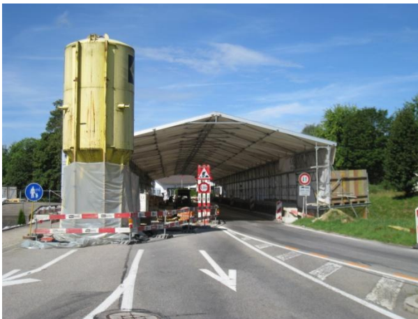
Eingehauste Brücke mit einstreifiger Verkehrsführung
