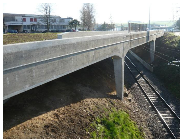
fertig instandgesetzte und verstärkte Brücke
