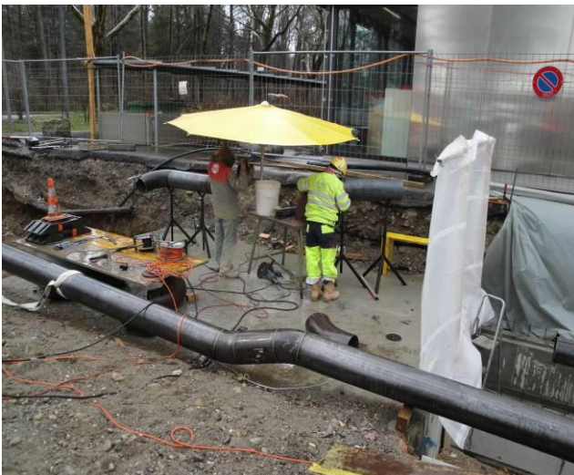
Schweissen der Stahlrohre NW 250 mm
