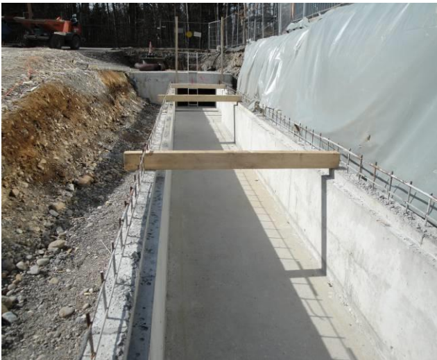
Betonkanal für Fernwärmeleitungen NW 250 mm
