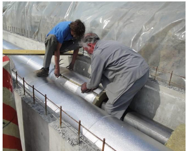
Isolieren der Fernwärmevor- und Rücklaufleitungen
