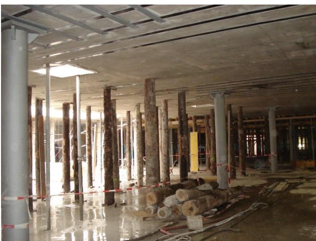
Anpassung Stützenraster und Deckenverstärkung
