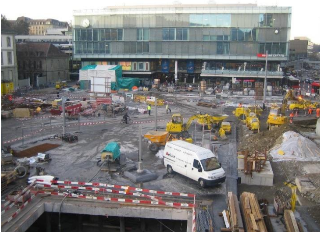
Bahnhofplatz während dem Umbau
