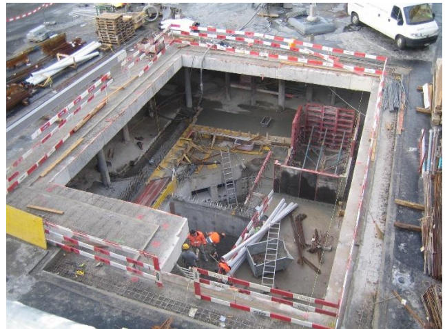
Christoffelunterführung: neue Treppenaufgänge
