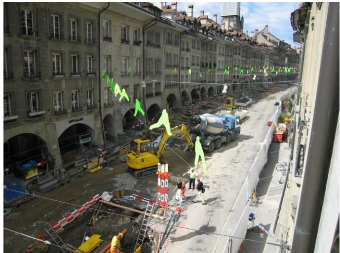
Intensivphase im Abschnitt Gerechtigkeitsgasse
