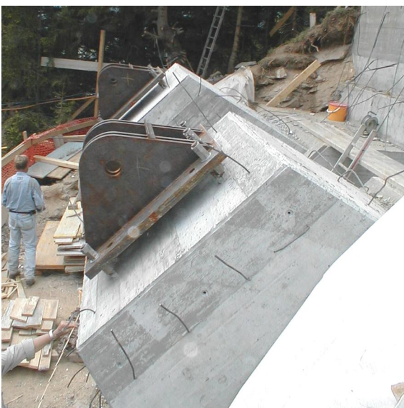
Fundamente der Stahlstiele mit Fussgelenk
