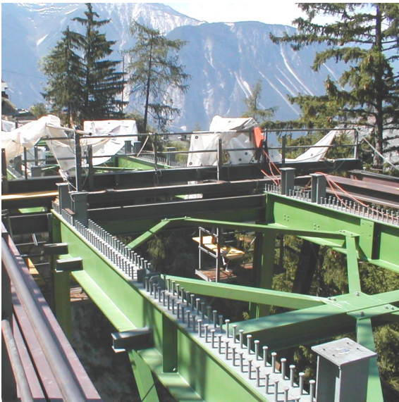
Stahlsprengwerk im Bauzustand
