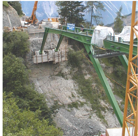
Montage des Stahlbaus
