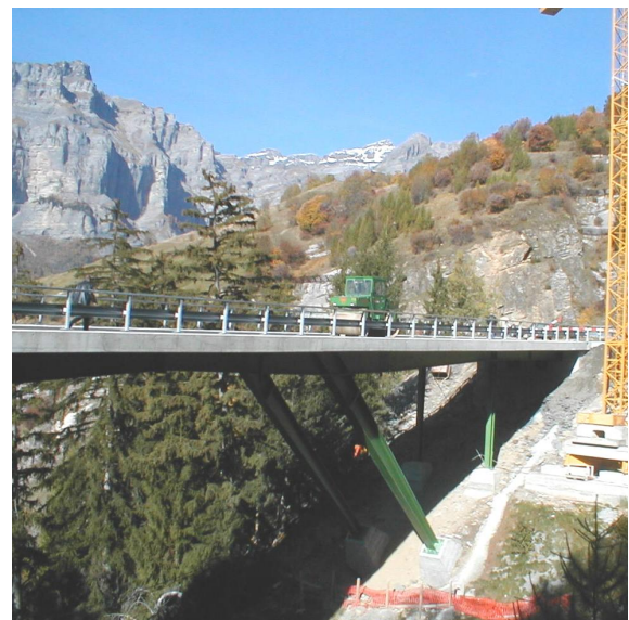
Brücke mit fertig erstellter Fahrbahnplatte
