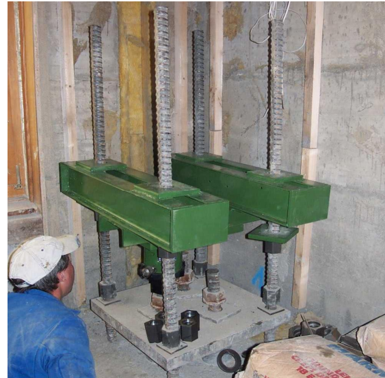
Pfahlgruppe während der Vorpressung mit 500 kN pro Pfahl
