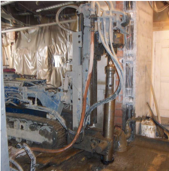
Elektrisches Kellerbohrgerät im Einsatz
